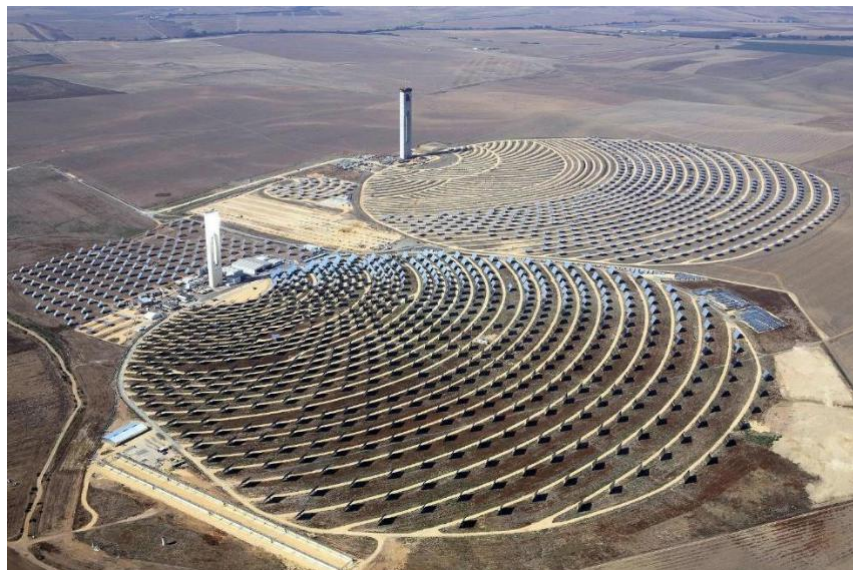
Εικόνα 1 Εργοστάσια PS10 και PS20 στην Ισπανία.
