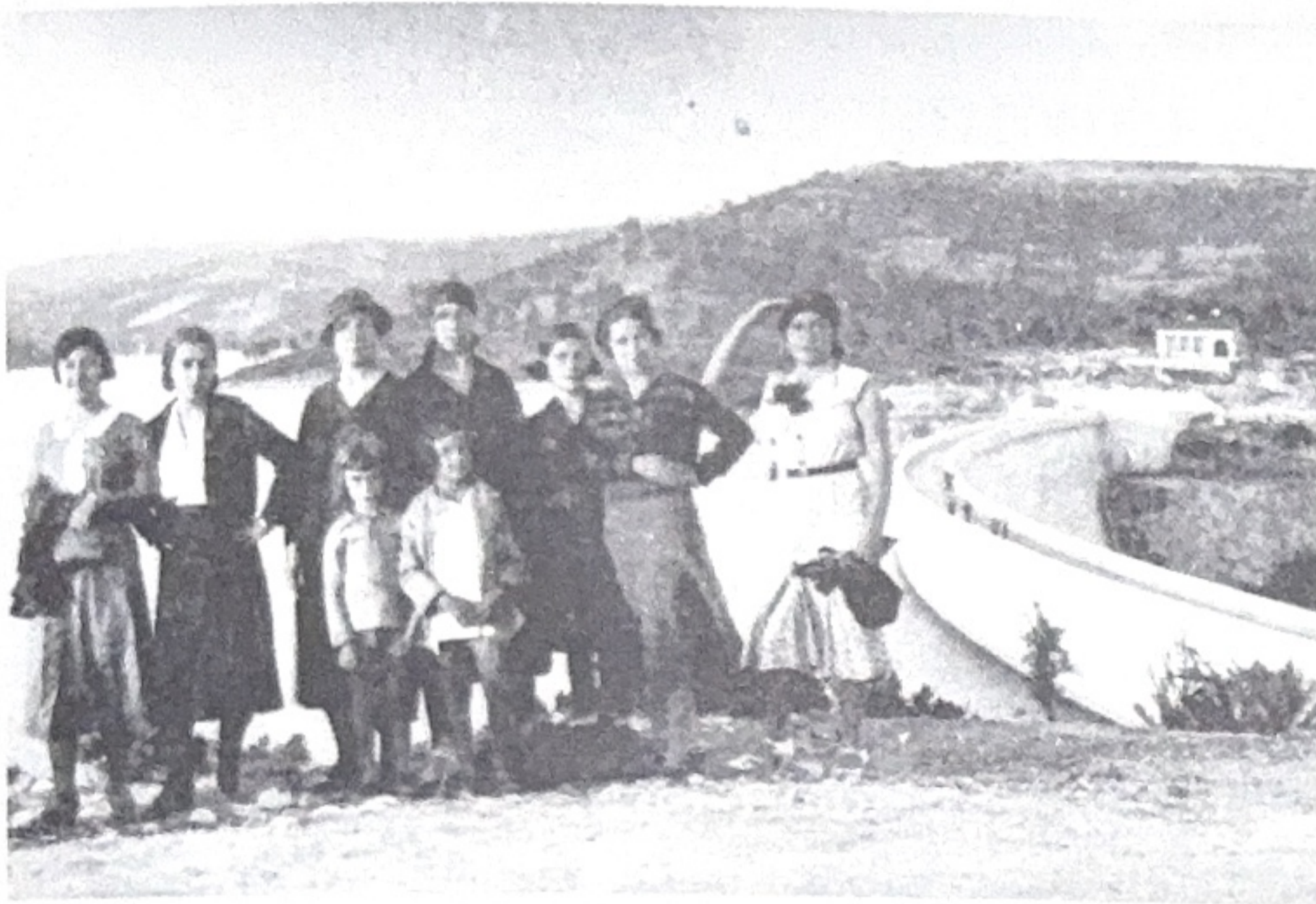
Δεκαετία 1930. Στο Φράγμα
