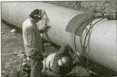
Εικόνα 7.1.8 Κατασκευή αγωγού μεταφοράς φυσικού αερίου στη Σιβηρία
