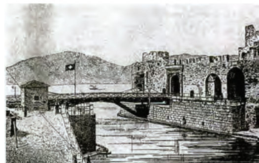
Η περιστροφική γέφυρα του πορθμού του Ευρίπον, με την οποία συνδέθηκε η Στερεά Ελλάδα με την Εύβοια Γεννάδειος Βιβλιοθήκη.
