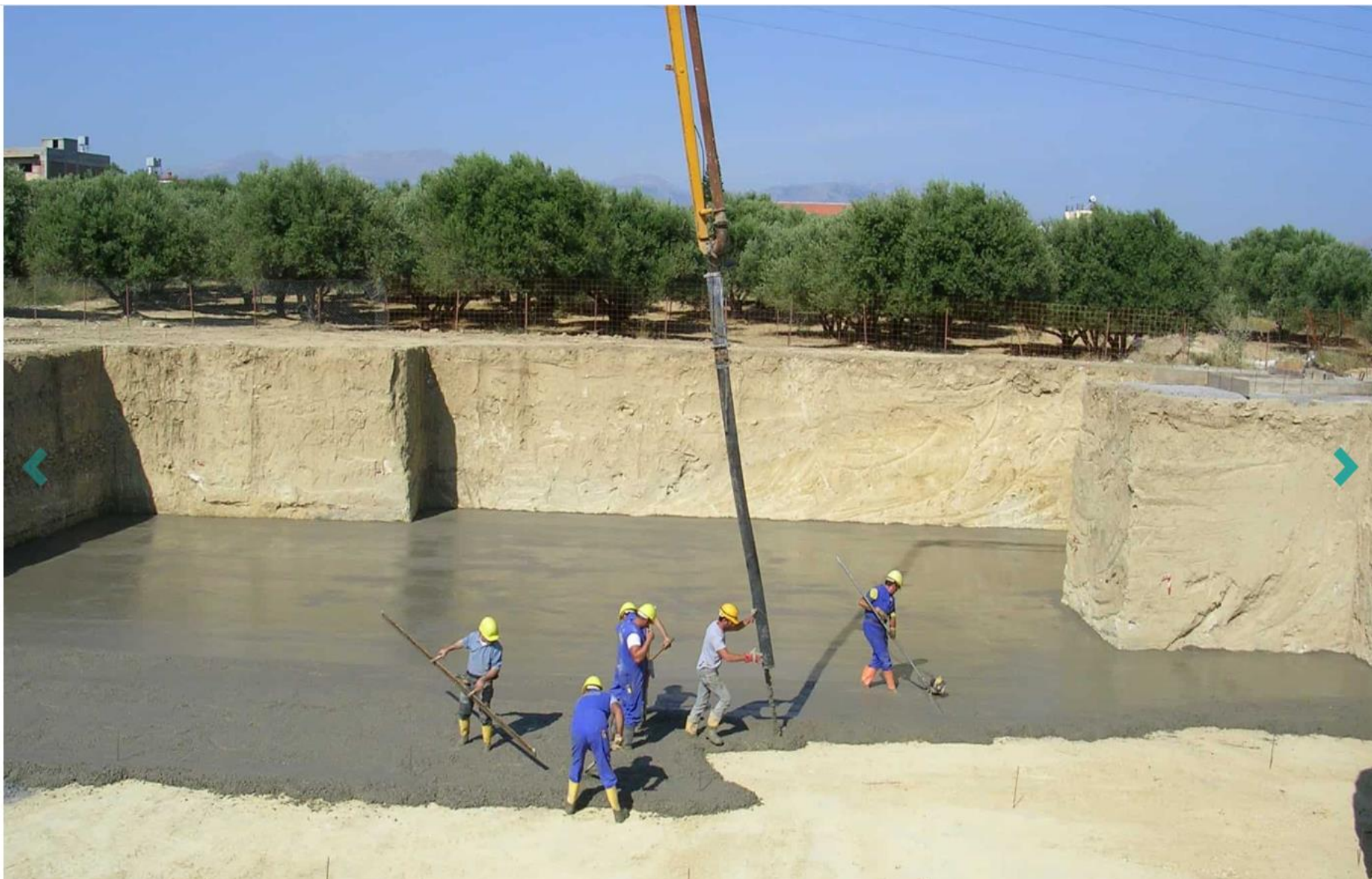
Σκυροδέτηση μπετόν καθαριότητας
