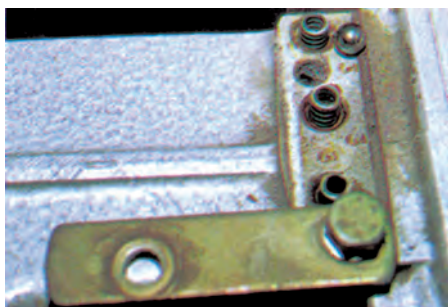
Σχήμα 15: Αφαίρεση της πλάκας συγκράτησης και των ασφαλειών.
