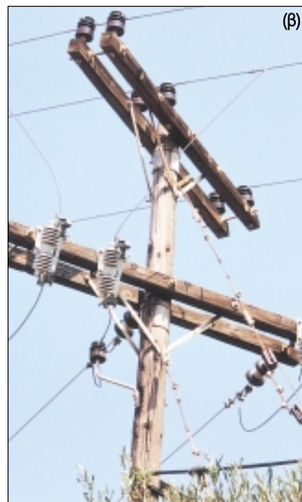
Εικόνα 1.1 Ηλεκτρικές γραμμές μεταφοράς (α) δίκτυο 150 kV (β) δίκτυο 20 kV (γ) υποσταθμός 150/20 kV
