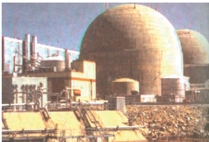
Εικ. 2.7 Πυρηνικό εργοστάσιο παραγωγής ηλεκτρικής ενέργειας στη Βιρτζίνια των Η.Π.Α. Παράγει ηλεκτρική ισχύ 900 MW και ταυτόχρονα αποβάλλει στο κοντινό ποτάμι θερμότητα με ρυθμό 2100 MW. Το εργοστάσιο αυτό όπως και τα υπόλοιπα του είδους του «πετάει» πολύ περισσότερη ενέργεια από όση αποδίδει σε χρήσιμη μορφή.
