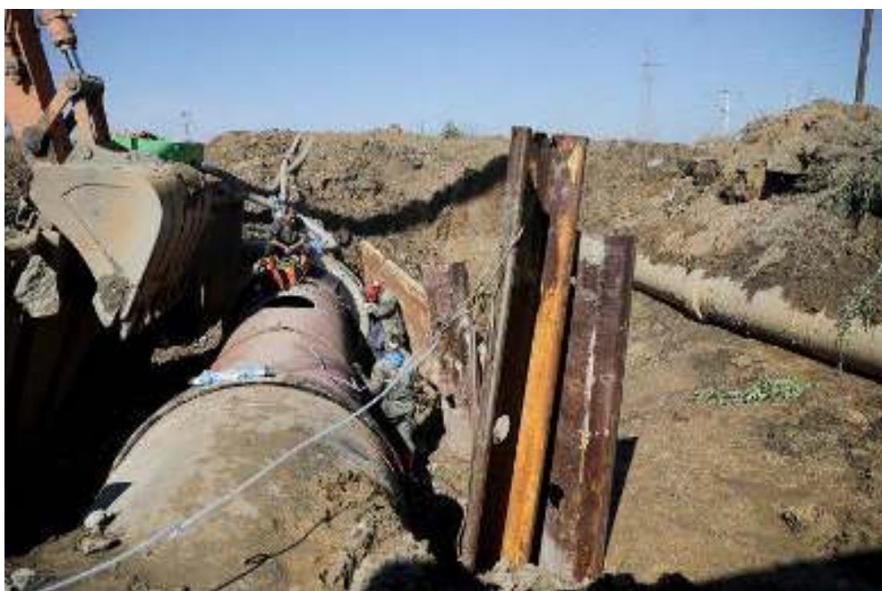
Εικόνα 4.4: Κατασκευαστικά έργα αποχετευτικού δικτύου Θεσσαλονίκης.
