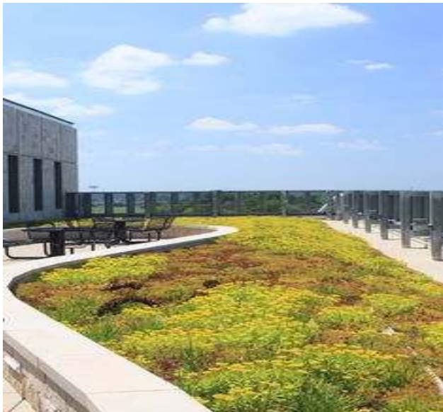
Εικόνα 3.3: Φυτεμένα δώματα (brickworks.com.au).
