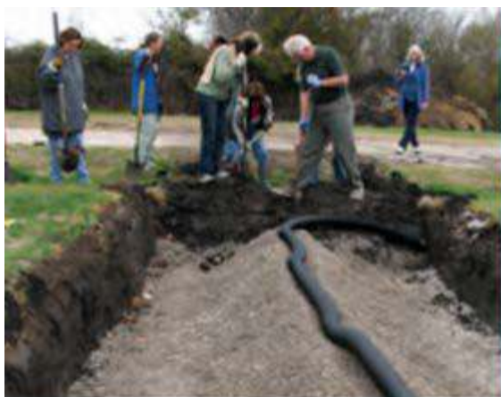
Εικόνα 3.9: Τοποθέτηση διάτρητου σωλήνα αποστράγγισης (Texas, 2013).
