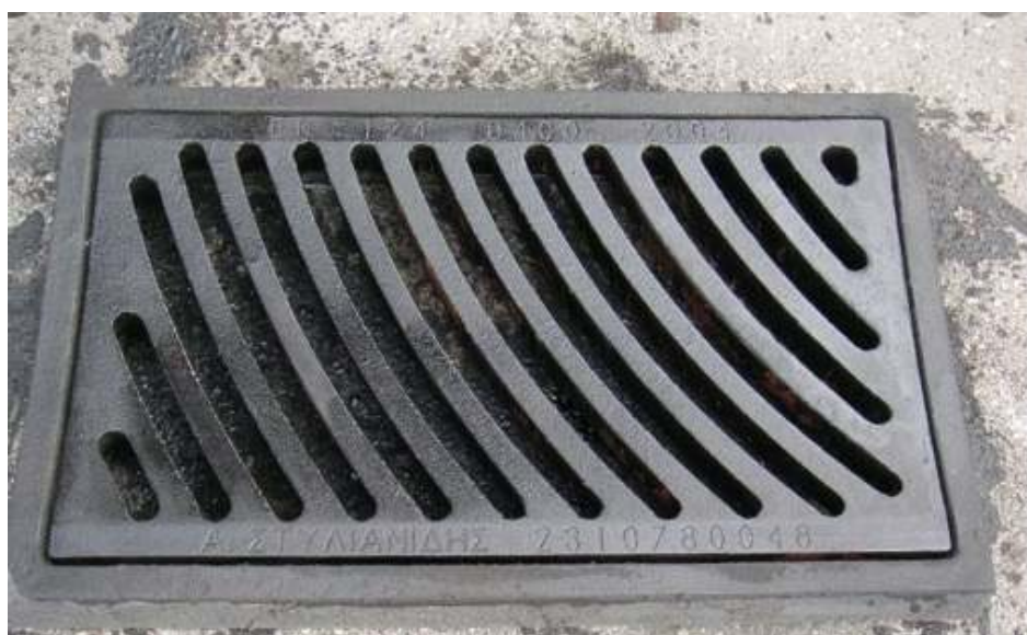
Εικόνα 6.4.2: Σχάρα υδροσυλλογής σε λειτουργία στην Εθνικής Αμύνης.
