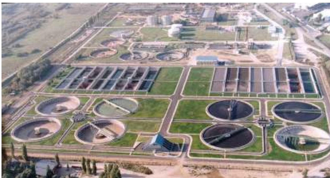
Εικόνα 4.5: Εγκατάσταση Επεξεργασίας Λυμάτων Θεσσαλονίκης (ΤΕΕ, 2018).
