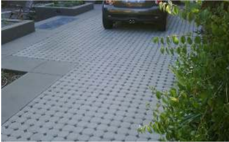
Εικόνα 3.4: Υδροπερατά πεζοδρόμια ( brickworks.com.au ).
