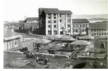
Τμήμα των εγκαταστάσεων της Γαλλικής Εταιρείας (CFML) στο Λαύριο
