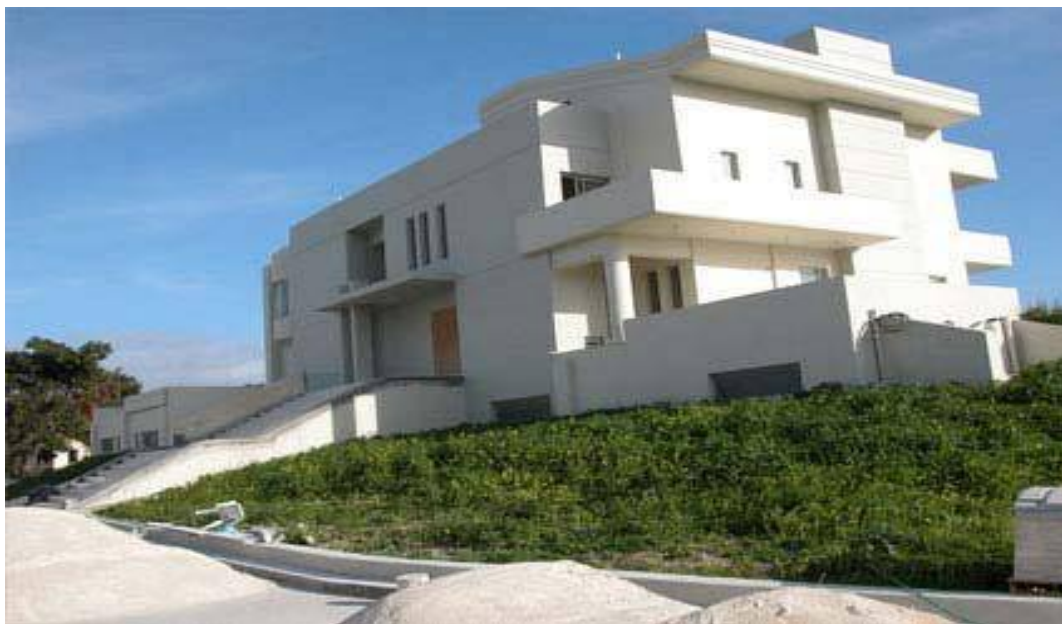
Ολοκληρωμένο σύστημα αυτοματισμού σε κατοικία στη Ρόδο.
