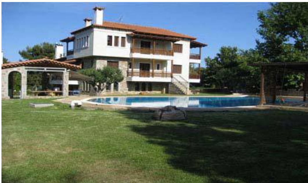
Ολοκληρωμένο σύστημα αυτοματισμού σε κατοικία.
