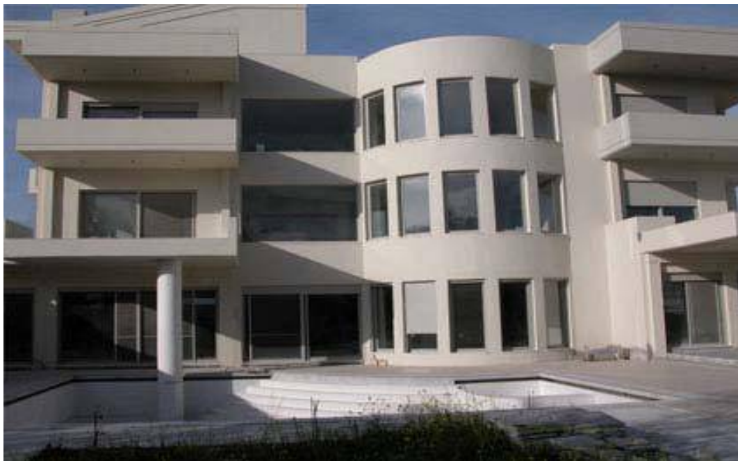
Ολοκληρωμένο σύστημα αυτοματισμού σε κατοικία στη Ρόδο.
