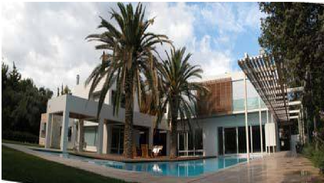
Ολοκληρωμένο σύστημα αυτοματισμού σε κατοικία.
