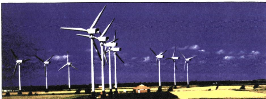
Εικ. 4.20. Εγκατάσταση ανεμογεννητριών ισχύος 3MW στο Emden της Γερμανίας.
