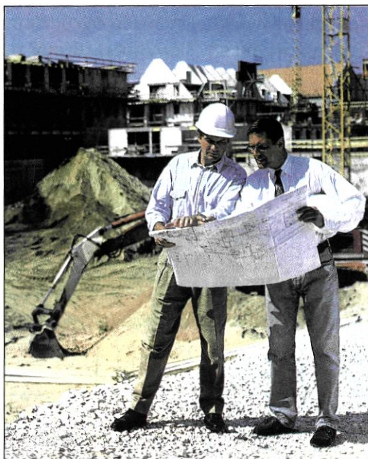
Εικ. 6.5. Εκσκαφές για θεμελίωση κτιρίου.
