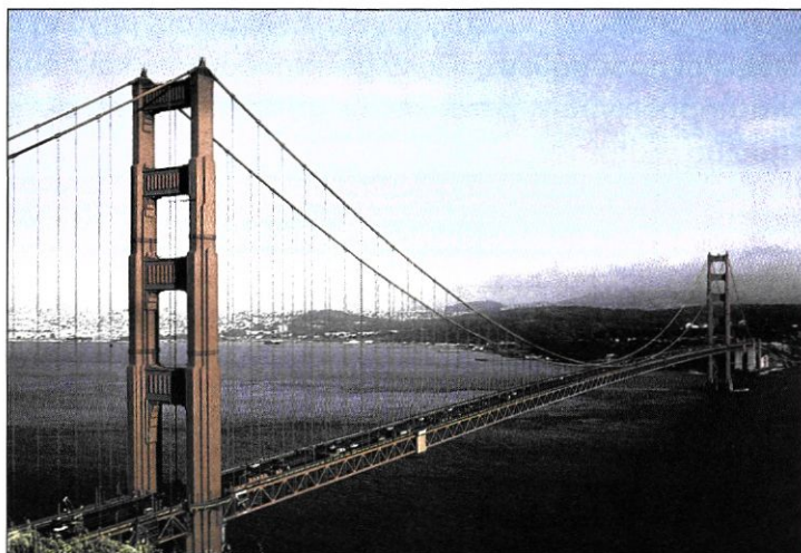
Εικ. 6.9. Κρεμαστή γέφυρα με μεγάλα ανοίγματα που βρίσκεται στην Καλιφόρνια των ΗΠΑ.
