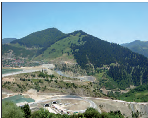
Σήραγγα στην Εγνατία Οδό
