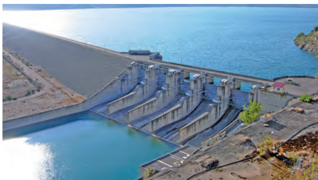
Το φράγμα και η τεχνητή λίμνη Στράτου
