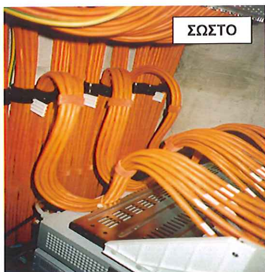
Εικόνα 50 Σωστή και λάθος αντίληψη της έννοιας του επιπλέον καλωδίου
