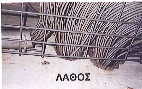
Εικόνα 40 Γεμάτος σωλήνας & Τρύπες χωρίς σωλήνα
