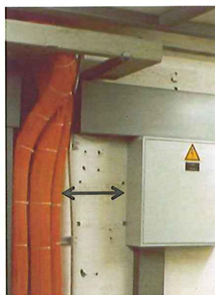
Εικόνα 45 Απόσταση μεταξύ καλωδίων δεδομένων και ηλεκτρικού πίνακα
