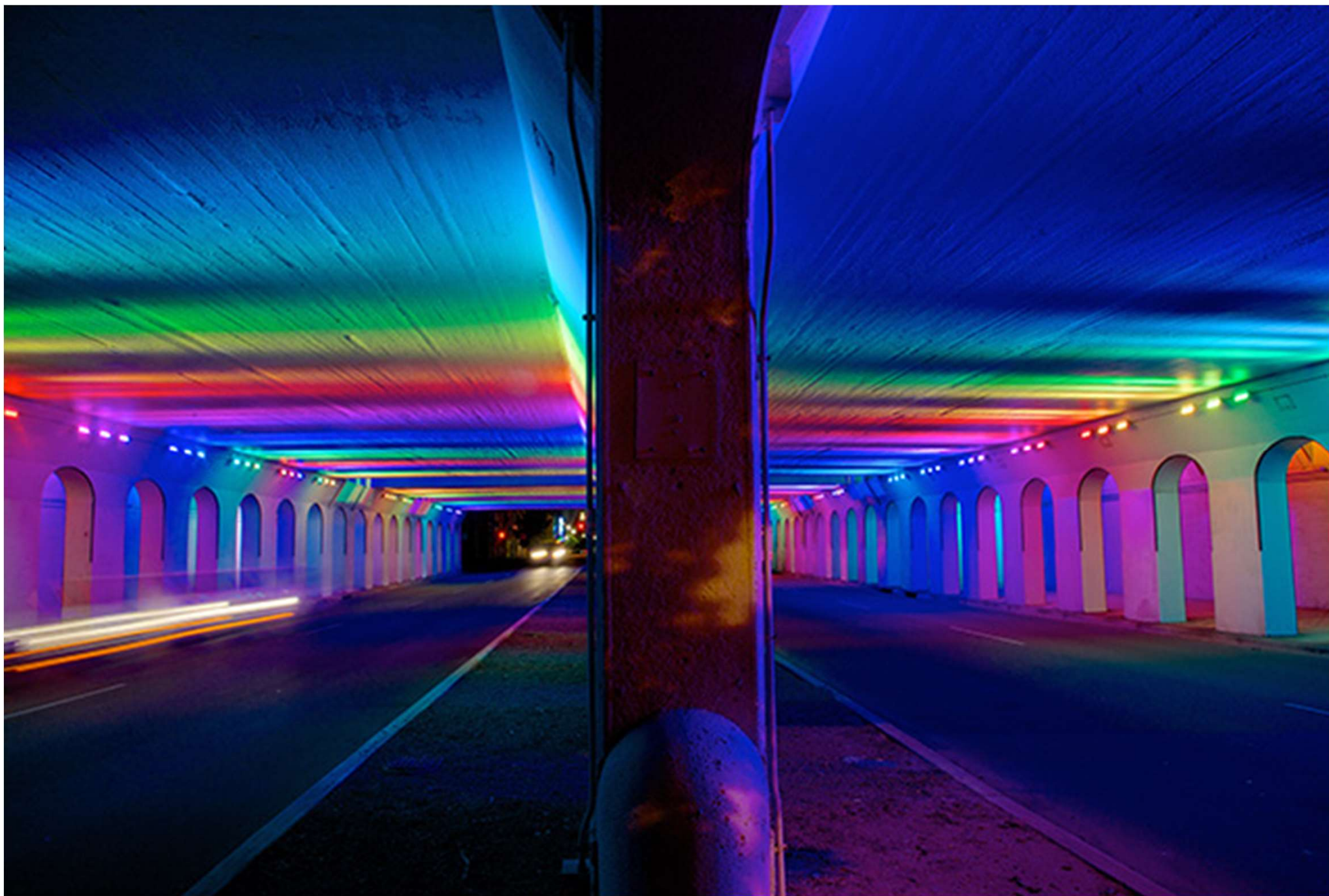
Φωτισμός σήραγγας μέσω ανάκλασης
