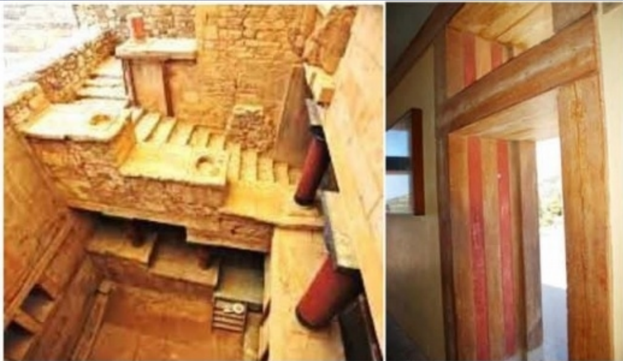
Εικόνα 4: Κνωσός, α. Κεντρικό κλιμακοστάσιο με κλιμακωτά στηθαία και κίονες, β. Λεπτομέρεια λιθόκτιστης κατασκευής σε συνδυασμό με ξύλινο σκελετό. Εδώ, στην αποκατάσταση Έβανς, το ξύλο αντικαθιστάται από μπετόν.
