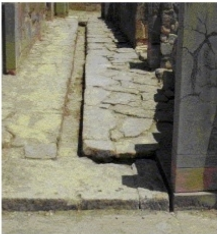
Εικόνα 3. Τμήματα του συστήματος αποχέτευσης στο ανάκτορο της Φαιστού: τμήμα εντός του ανακτόρου (αριστερά) και κεντρικός αποχετευτικός αγωγός (δεξιά).
