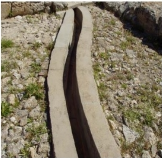
Εικόνα 2. Τμήματα του συστήματος αποχέτευσης στο ανάκτορο της Κνωσού, εντός του ανακτόρου (αριστερά) και στην έξοδο του κεντρικού αποχετευτικού αγωγού (δεξιά).
