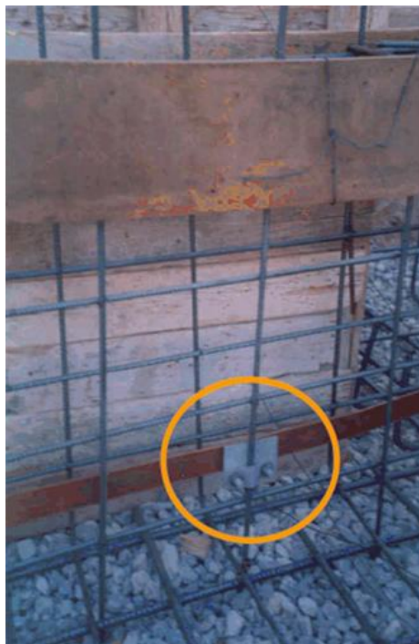
Σχήμα 3.19. Σφιγκτήρες και τοποθέτηση θεμελιακής γείωσης.
