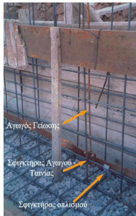
Σχήμα 3.19. Σφιγκτήρες και τοποθέτηση θεμελιακής γείωσης.
