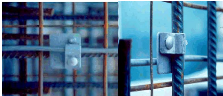
Σχήμα 3.17. Σφιγκτήρες θεμελιακής γείωσης.
