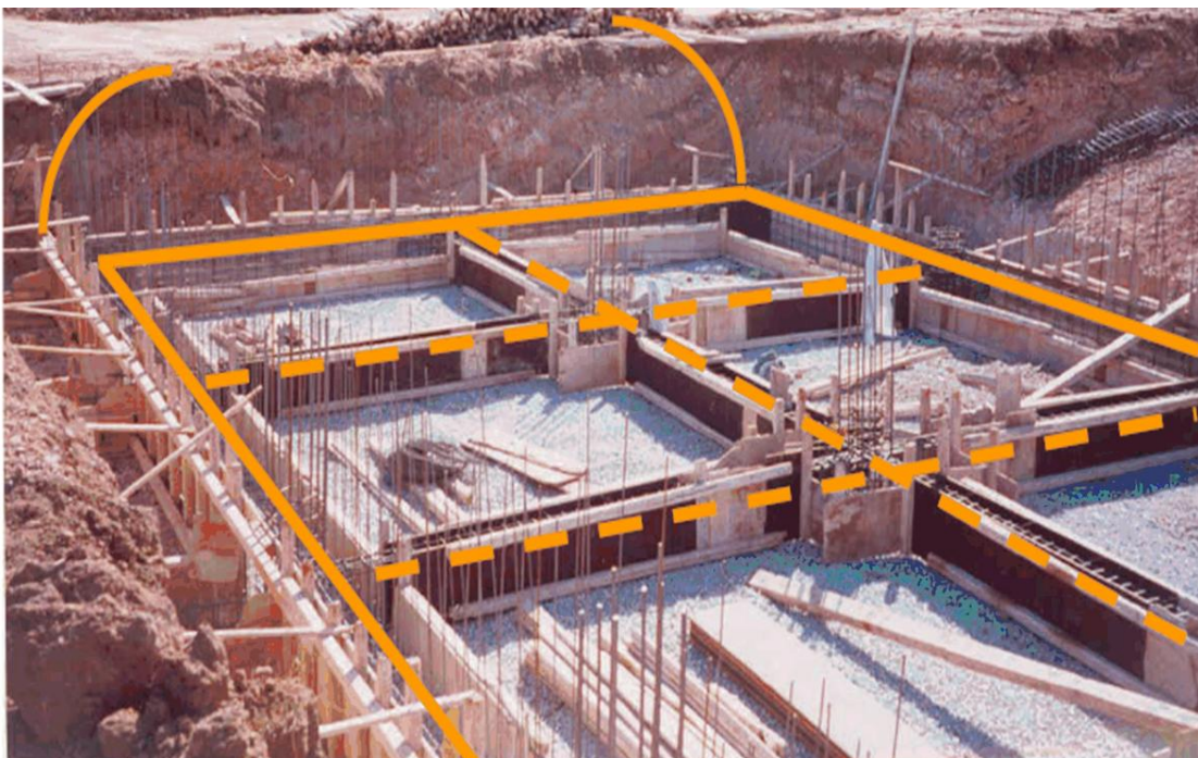
Σχήμα 3.14. Κύριες και δευτερεύουσες διαδρομές αγωγών θεμελιακής γείωσης.
