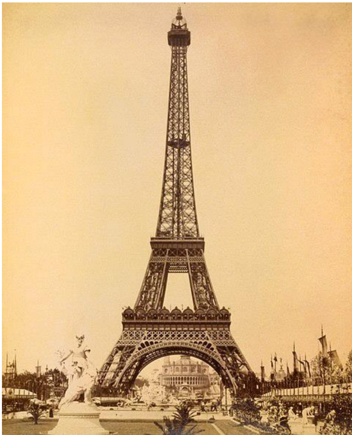
Εικ.2 «ΠΥΡΓΟΣ ΤΟΥ ΑΙΦΕΛ», 1889, ΓΚ. ΑΙΦΕΛ
